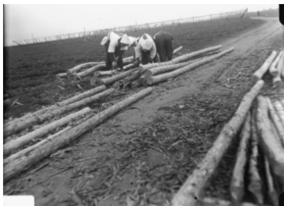
3858 平出遺跡住居復元作業風景 昭和26年
