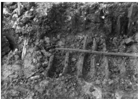
2756 第1号住居跡環柵補強状況 昭和18年8月
