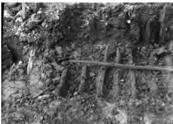
2756 第1号住居跡環柵補強状況 昭和18年8月
