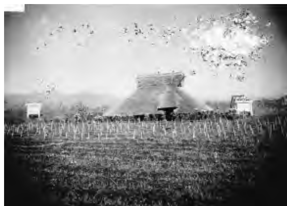
2627 復原された家屋 昭和26年
