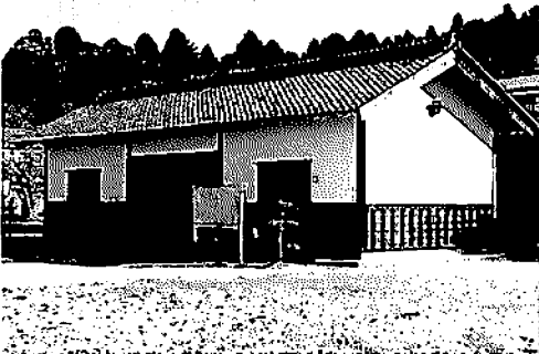
移築された知新館正門。左側に釈奠の間の復元されている。
