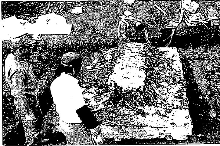
8 離型の完成(反転した状況)
