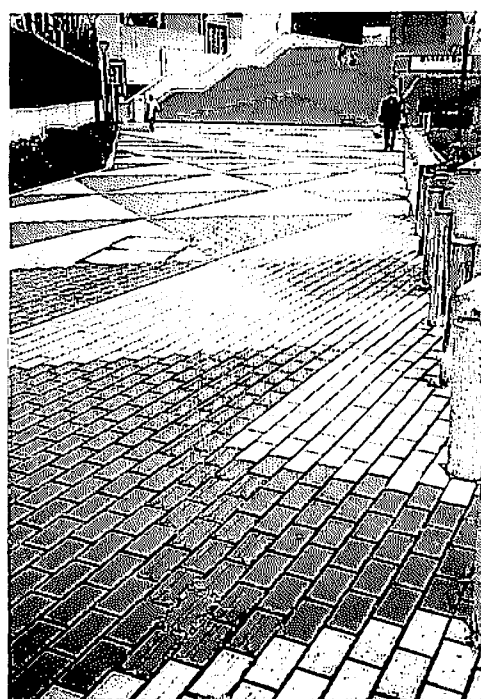
写真25(上) 剥がれた点字ブロック
