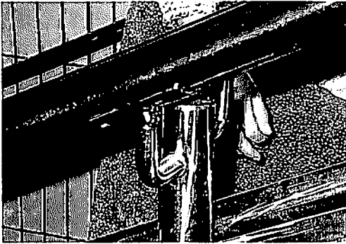
写真30 安全性に問題のある手すり
