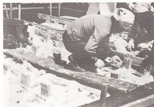
写真 11. 搬出後の現地再元の場合に必要な工程。 海拔、位置(グリッド)、斜角度等を記憶させる。
