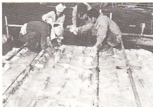
写真 9. さらに木組、枠を形成し、パネル状とする。
