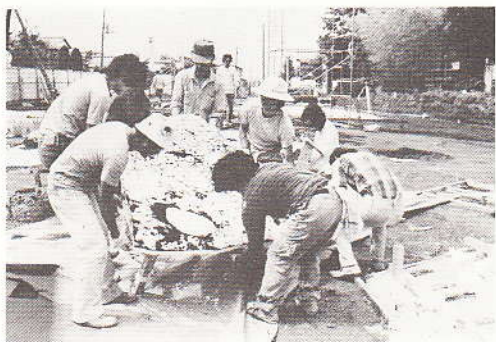
写真 26. ( 搬 出 ) 日照で乾燥させ、附着の土を払い落す。石膏材のため、水洗いは避ける。
