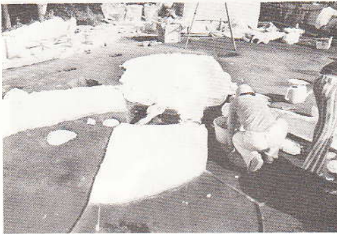
写真 18. 広い面積の場合は足場の関係上、対角区分順に流し込む。 乾燥約 80 分。
