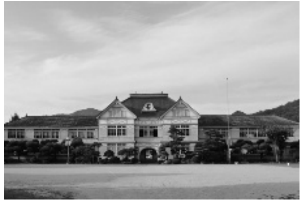
写真2 旧遷喬尋常小学校校舎
