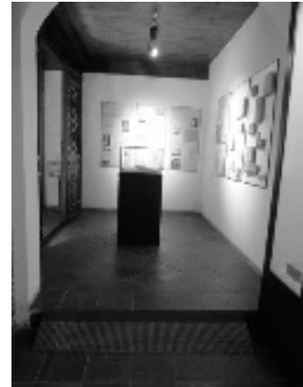
写真17 西安于右任故居紀念館の蹴放に設置されたスロープ
